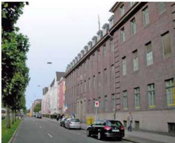
Bild 1: Außenansicht der radiologischen Praxis in der Luegallee, Düsseldorf.
