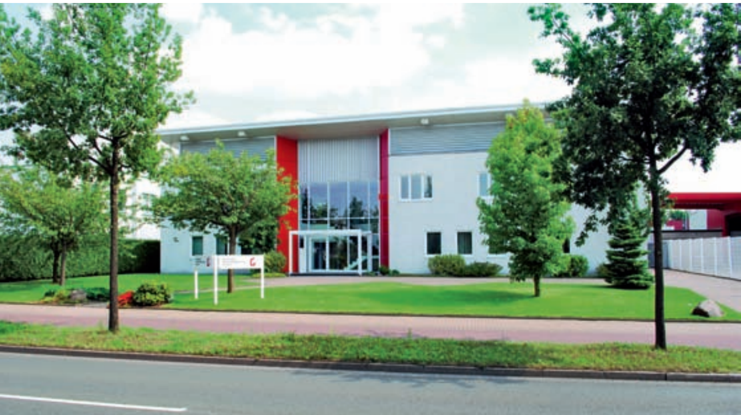
Bürogebäude in Dortmund-Wickede der Firma Gebäude Automatisierung GmbH
