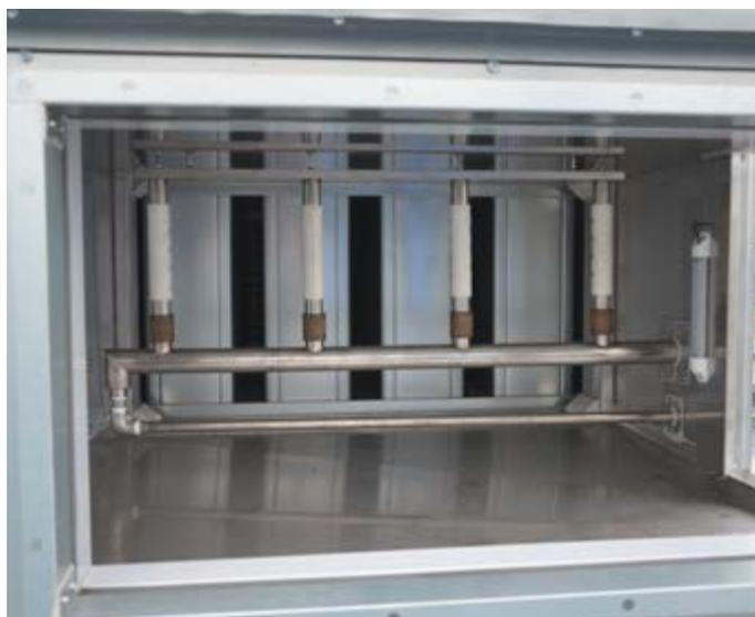
*Patentierter Isolierung der Dampfverteilerrohre zur Reduzierung der Kondensatentwicklung um bis zu 60 %*
