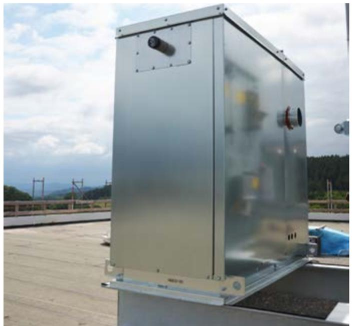
*driSteem Gasdampfbefeuchter zur Dampferzeugung auf dem Gebäudedach*
