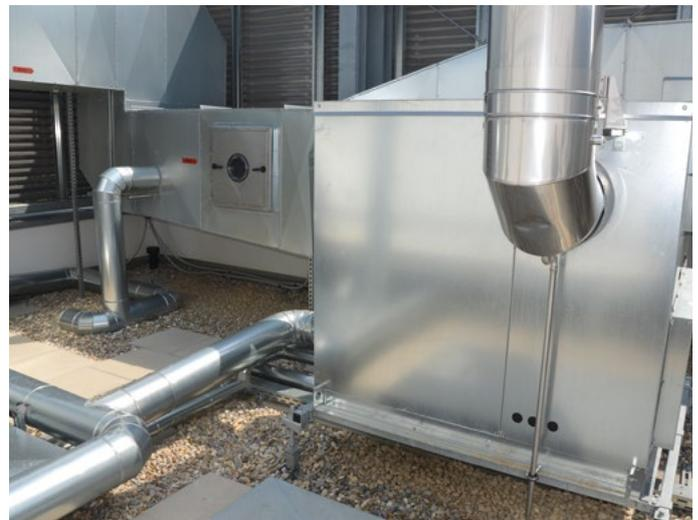
Geteilte Dampfleitung zur 50/50-Versorgung der Dampfverteilsysteme
