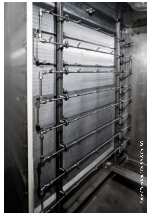
Die Anti-Tropf-Düsen im Luftkanal der raumluftechnischen Anlage
