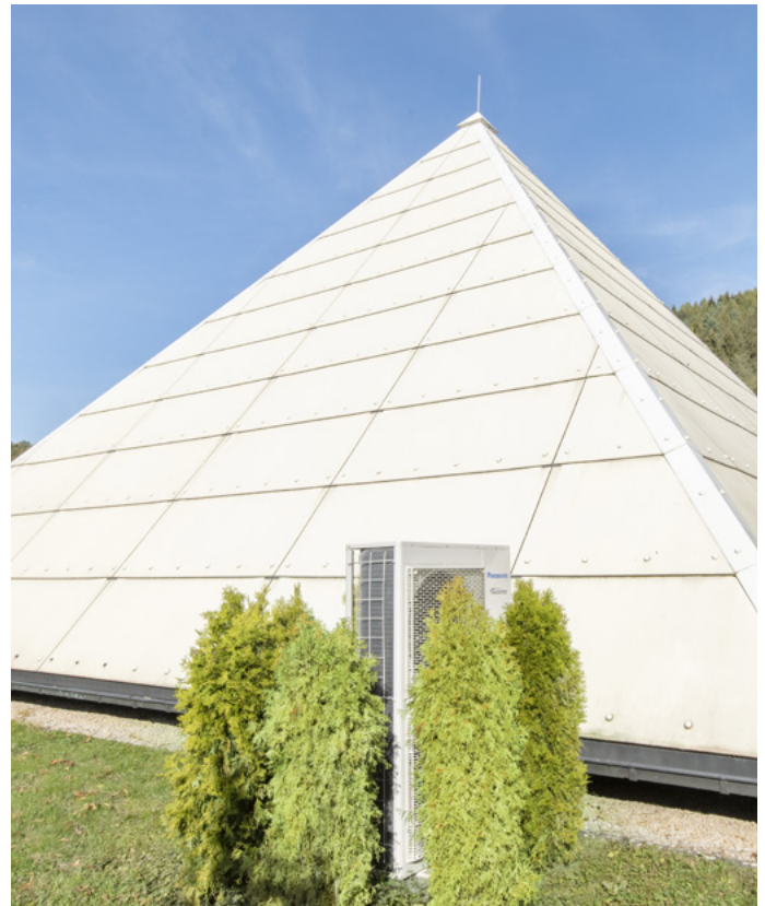
PACi Außeneinheiten mit vertikalem Luftausblas
