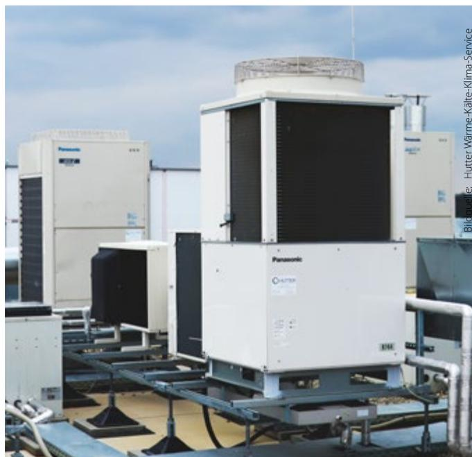
Die auf dem Gebäudedach installierte CO<sub>2</sub>-Außeneinheit von Panasonic
