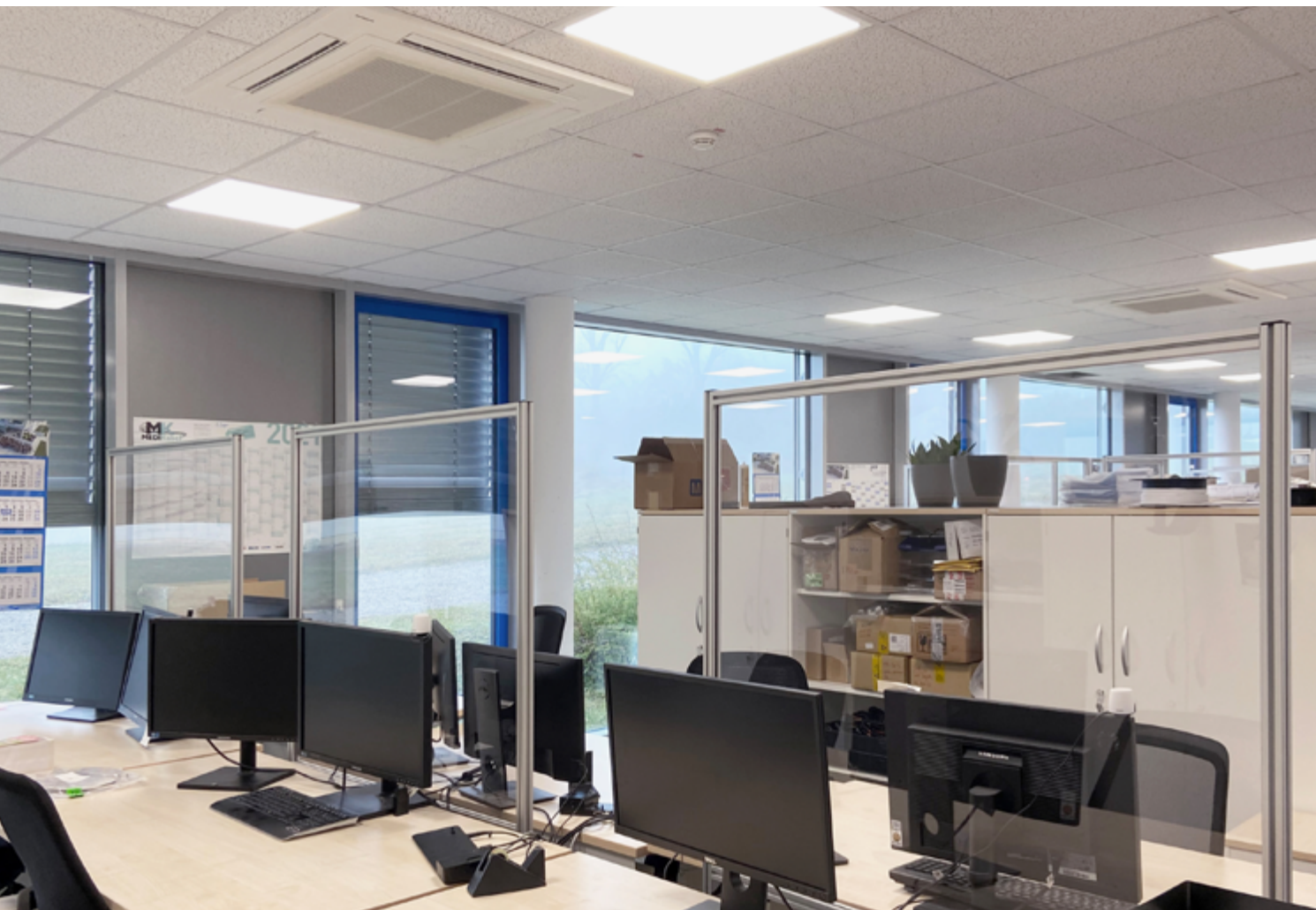
Panasonic Deckenkassetten mit integrierter nanoe™ X-Luftreinigungstechnologie
