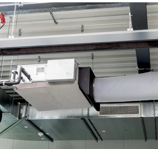
Kanalgerät mit max. 4300 m 3 /h für Umluft- oder 100% Frischluftbetrieb
