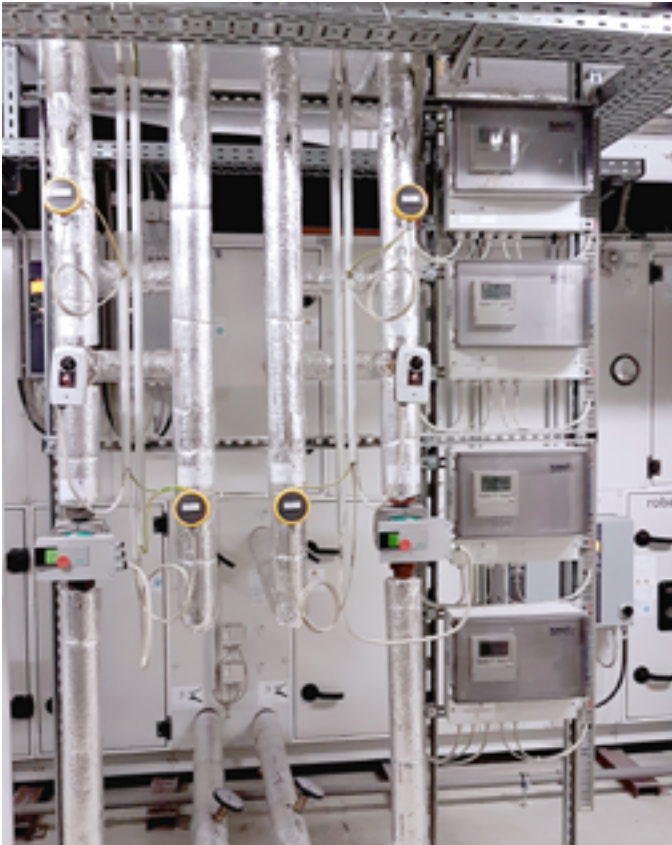
EKFEV Direktverdampfer-Kit für die Verbindung zwischen der Außeneinheit und dem Wärmeüberträger in dem Lüftungsgerät
