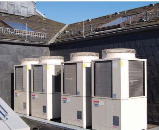
lweise gleichzeitig heizen und kühlen und sparen somit durch die Wärmerückgewinnung einen großen Teil an Energie ein.
