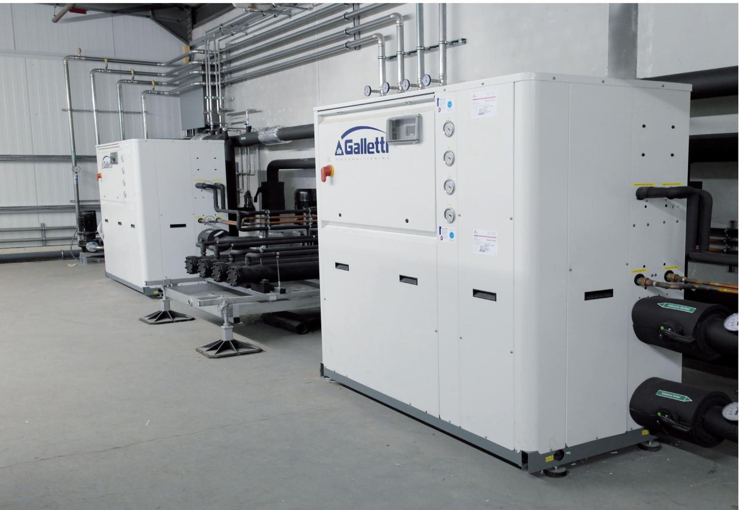
Zwei parallel aufgestellte identische Kaltwassersätze von GALLETTI für einen redundanten, unterbrechungsfreien Systembetrieb
