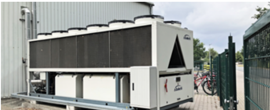
LSE800CL 564,3 kW Kälteleistung bei -2 °C Vorlauftemperatur
