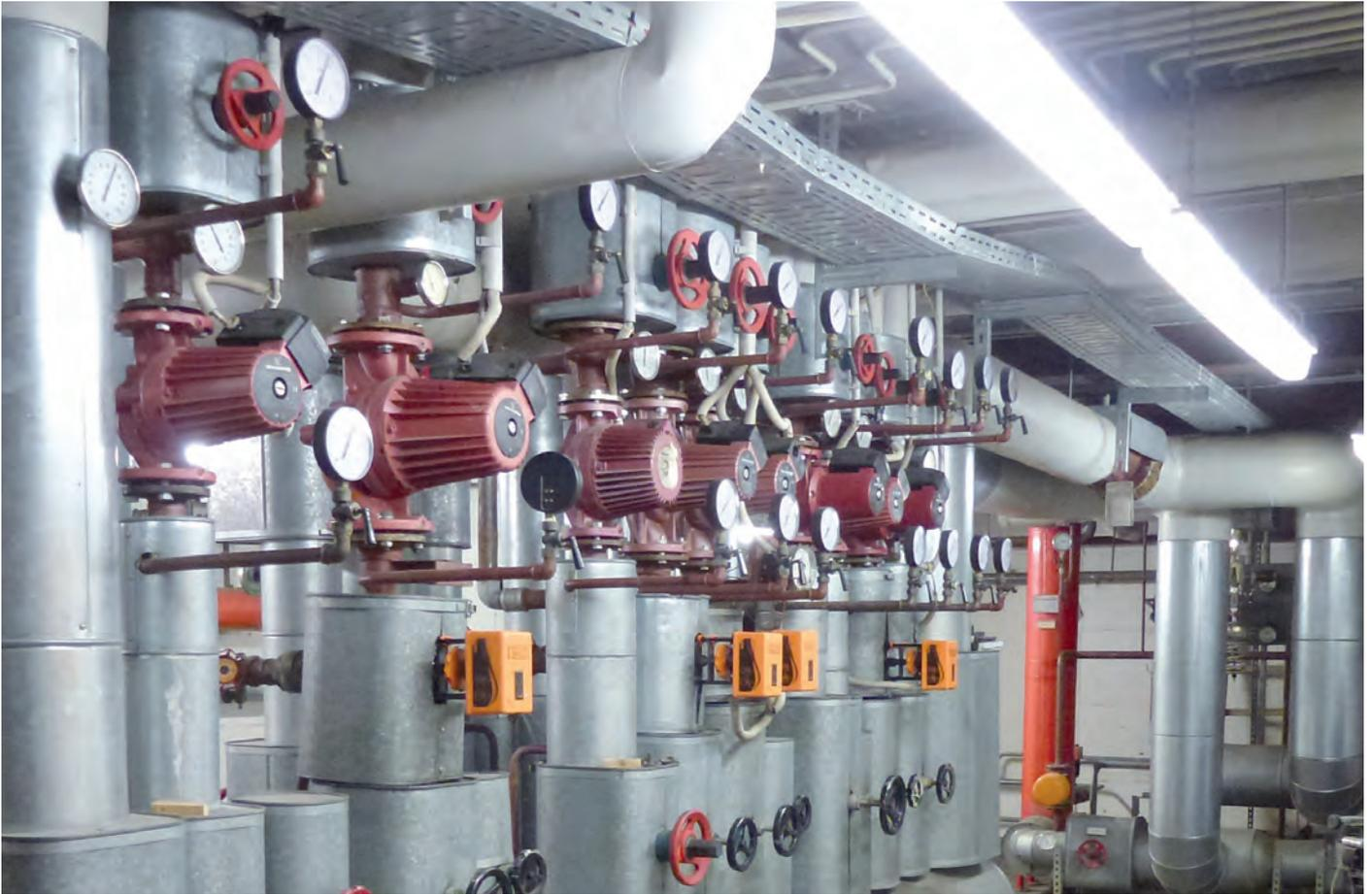
henden Wasserkreis. Über einen Außentemperaturfühler erfasst das PCO-Regelorgan die aktuelle Außenlufttemperatur und erzeugt eine gleitende Temperaturregelung. Zum einen dient dies im Kühlmodus zur Anpassung an die veränderten Lastbedingungen, zum anderen wird im Wärmepumpenmodus den niedrigen Außenlufttemperaturen entgegengewirkt. Zusätzlich passt der Regler automatisch die Systemparameter bei geringer Anforderung der Verbraucher an.
