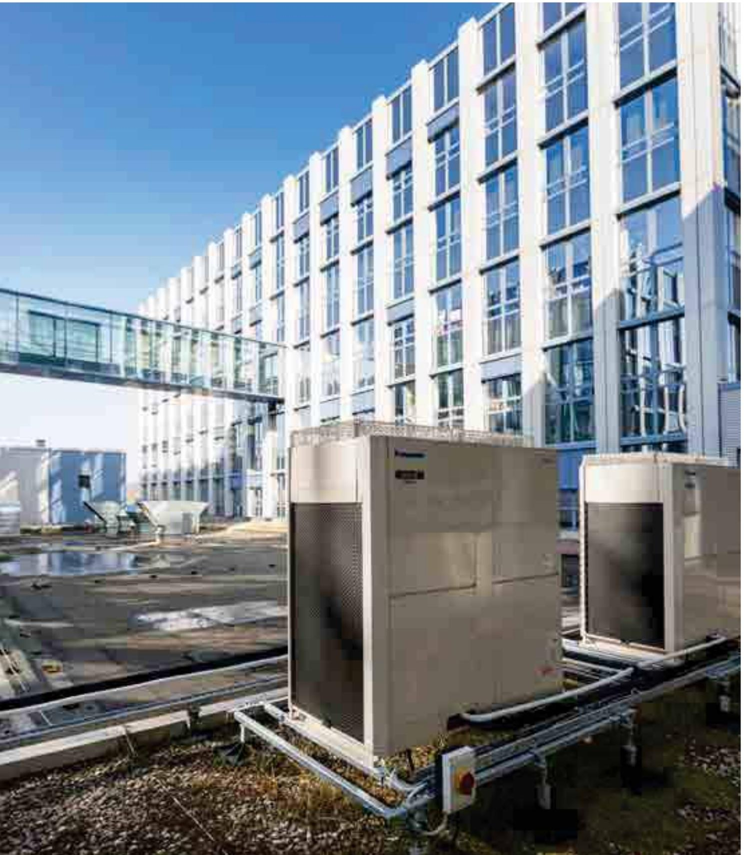
Neue VRF-Systeme der Baureihe ECOi EX mit herausragender Energieeffizienz bei Hochleistungsbetrieb (ESEER = 9,33 beim 8-PS-Gerät).
