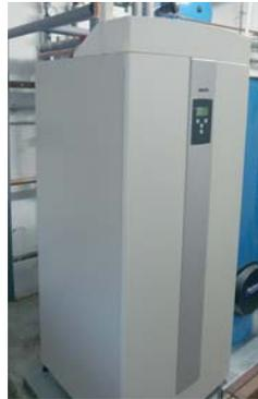
Das ist die neue 9 Kilowatt-CO<sub>2</sub>-Wärmepumpe im Keller der Familie Köllner.
