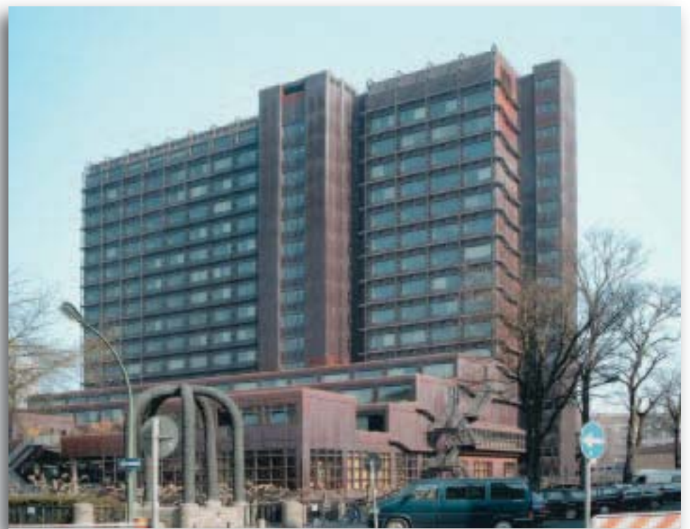
Im Landesamt für Daten und Statistik in Düsseldorf werden durch eine Kaut-Luftbefeuchtung 1158 kg Dampf in der Stunde erzeugt.
