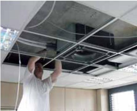
Einbau einer RAI 25 Hitachi Inneneinheit in die Euro-Rasterdecke eines Büroraums
