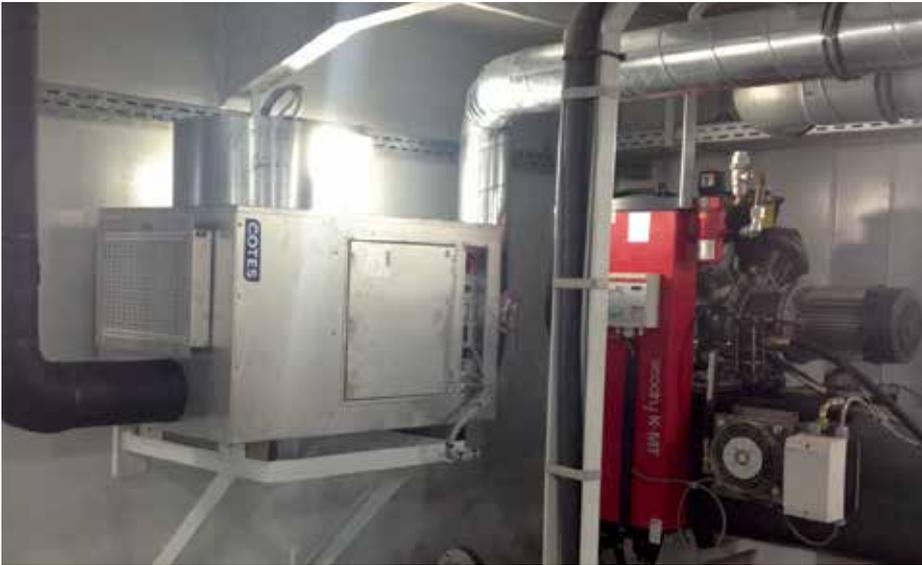
Cotes-Adsorptionstrockner im Pumpenraum des Schiffes
