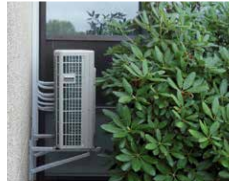
Wandinstallation einer RAM-70, die bis zu 4 Inneneinheiten versorgen kann
