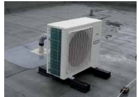
Eine RAM-90 oben auf dem Dach montiert.
