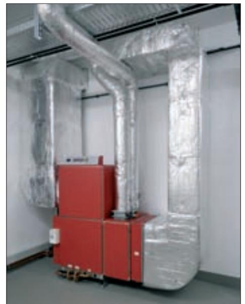
*Das ist der Variheat (AA600). An der Konsole können Temperatur und Luftfeuchtigkeit reguliert werden.*
