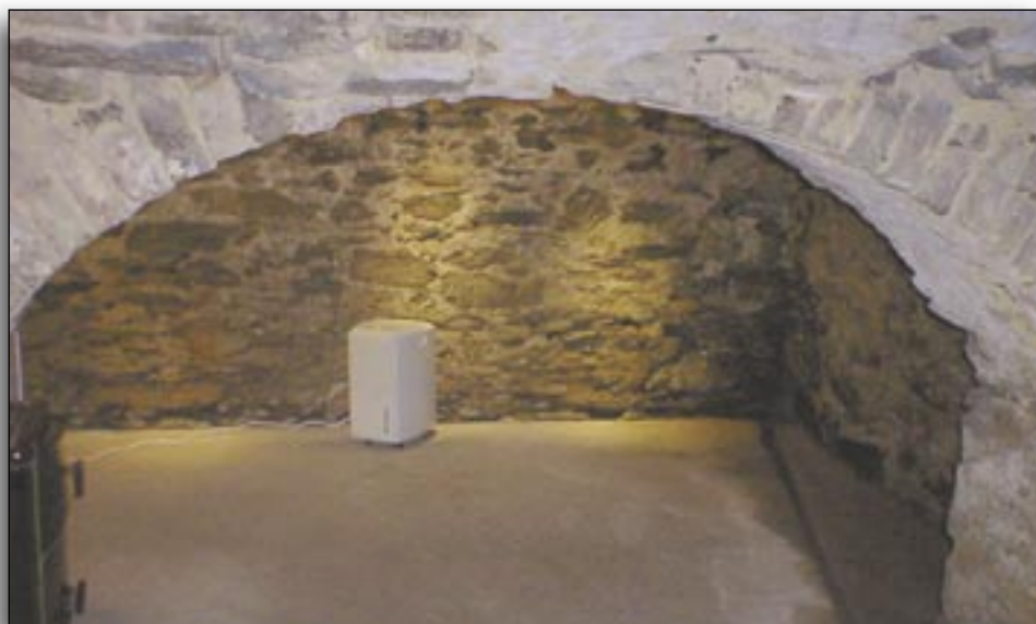
Aus einer „Tropfsteinhöhle“ wurde ein trockener Schulungsraum.
