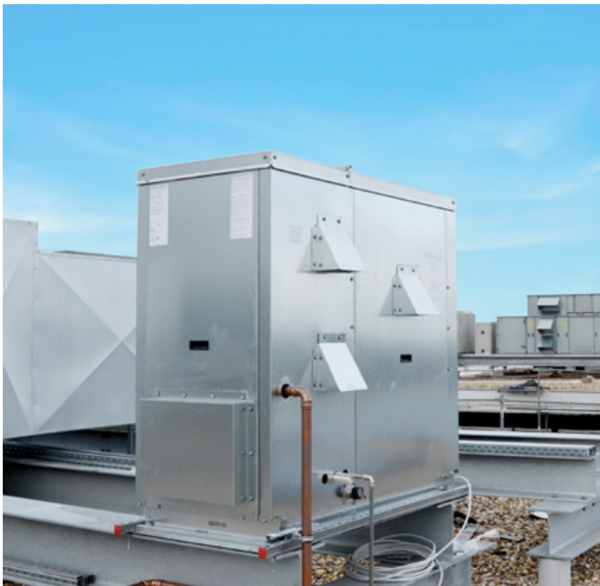
driSteem Gasdampfbefeuchter mit einem witterungsbeständigen Außengehäuse auf dem Gebäudedach - eines der effektivsten und unter Verwendung von Osmosewasser auch eines der wartungsärmsten Geräte für hygienisch saubere Luftbefeuchtung
