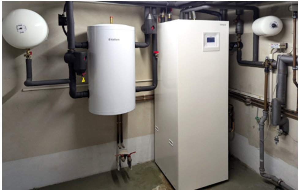
Das Kombimodul inklusive integriertem Warmwasserspeicher
