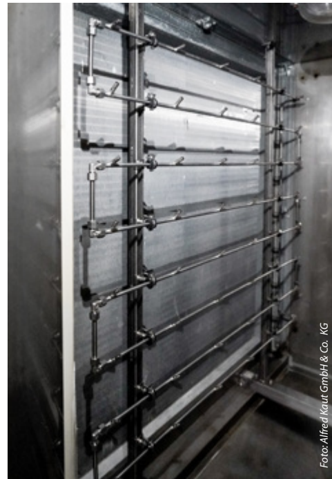
Die Anti-Tropf-Düsen im Luftkanal der raumluftechnischen Anlage
