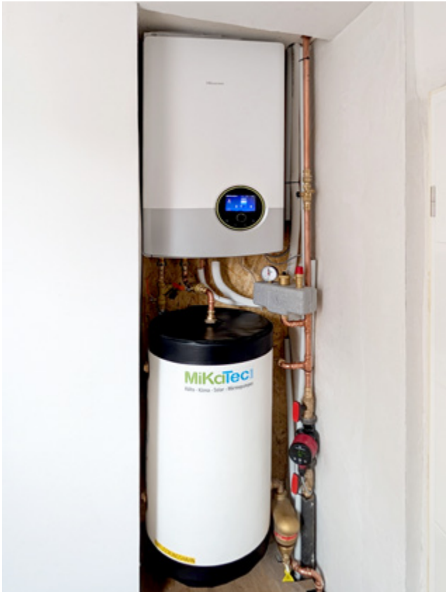
Inneneinheit und 150-Liter-Pufferspeicher
