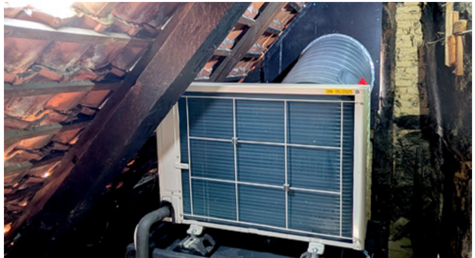
AHW-120 Außeneinheit von Hisense im Spitzboden des Gebäudes
