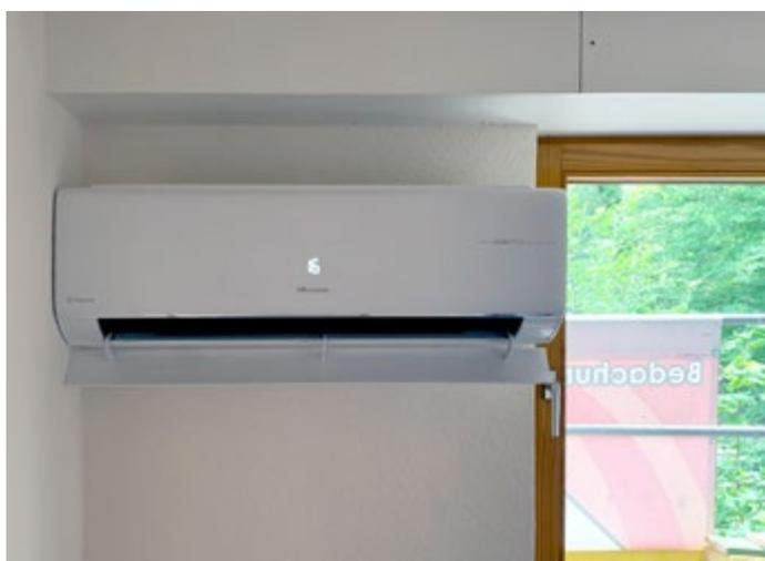
**An der Außenwand montiertes Innengerät**, der Frischluftschlauch wurde gerade aus nach hinten herausgeführt, andere Schlauchführungen sind problemlos möglich.
