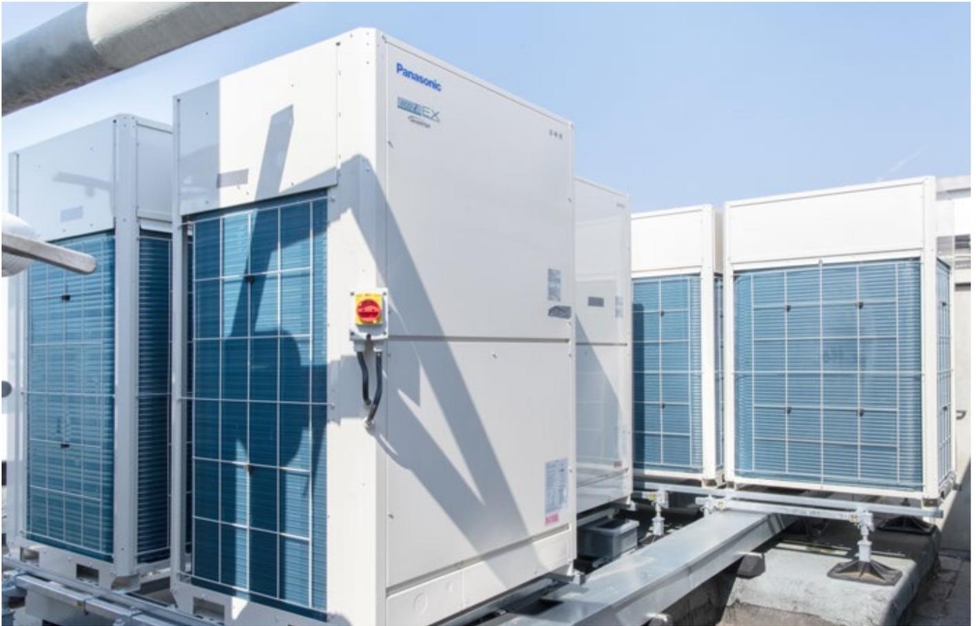
Auf dem Dach montierte **VRF-Außeneinheiten von Panasonic**
