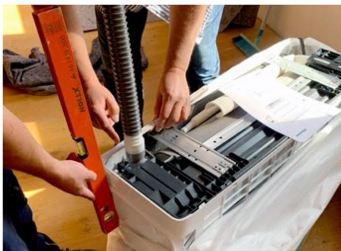
**Der Schlauch für die Frischluftzufuhr wird einfach an den vorgesehenen Anschluss gesteckt**, bei Bedarf kann er gekürzt oder verlängert werden.
