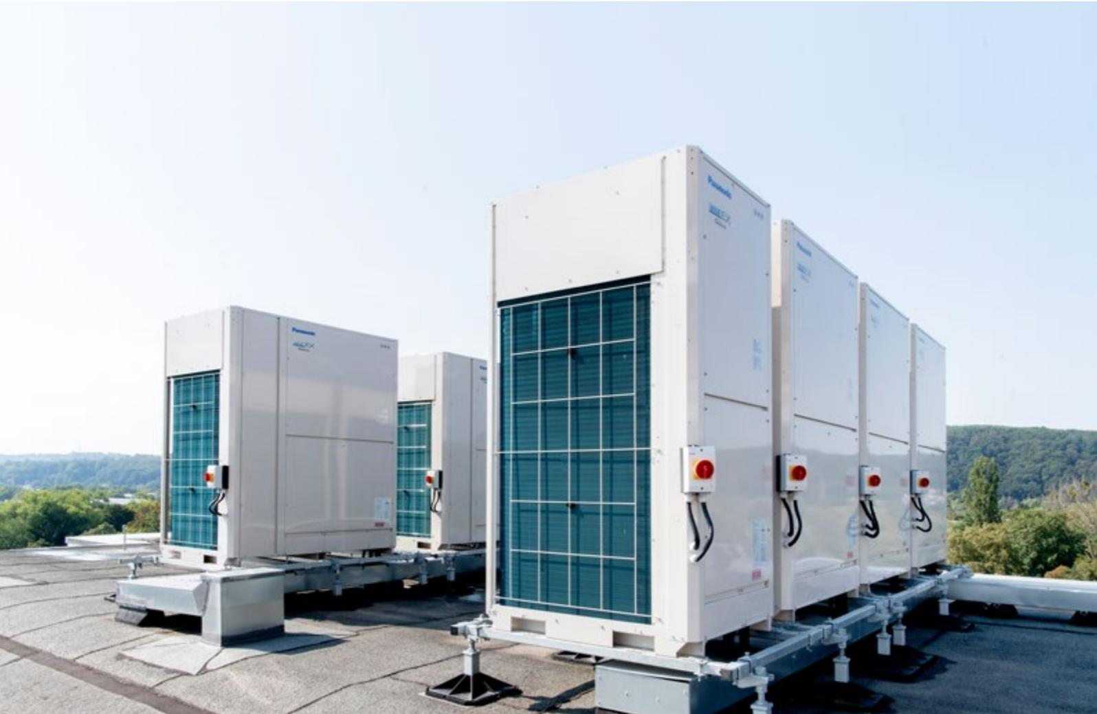
**VRF-Systeme mit 703 Innen-, 33 Außeneinheiten und 3 Aquarea Luft/Wasser-Wärmepumpen** in mehreren Bauabschnitten installiert (S. 8)
