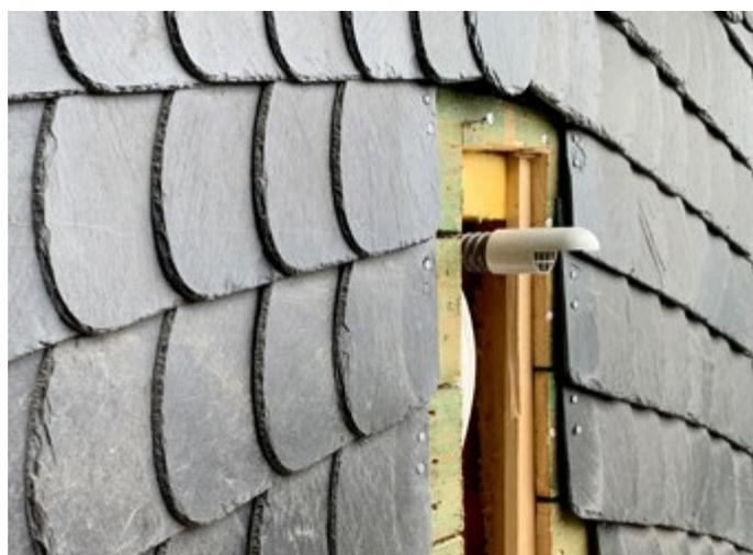
**Von außen ist lediglich nur der Lufteintritt für die Frischluftzufuhr sichtbar**, die Rohrleitungen wurden hinter der verschiefernten Fassade verlegt.
