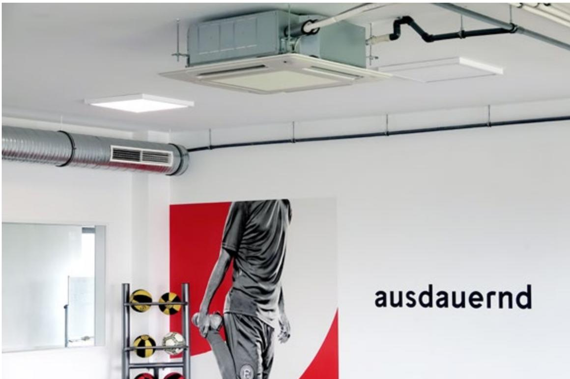
Im Trainingsraum montiertes **4-Wege-Kassettengerät** von Hitachi
