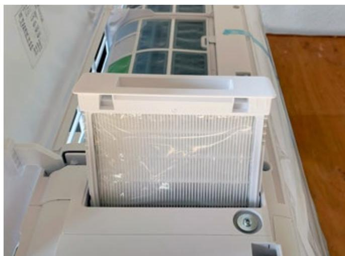
**Für die direkte Reinigung der Außenluft ist ein PM2.5 Filter integriert**, der über ein Schubfach einfach entnommen und gereinigt wird.
