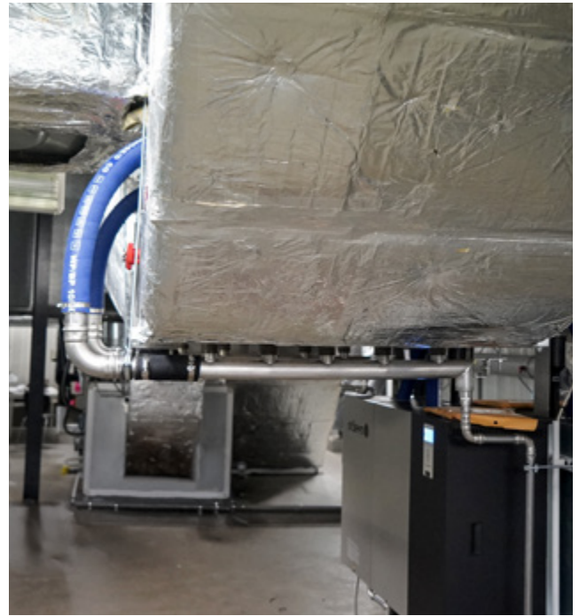
Optimierte Dampfeinbringung mit dem Rapid-Sorb®-System von DriSteem
