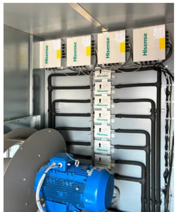
*Die HZX-Kits von Hisense regeln die thermische Energieübertragung im Luftkanal per 0–10 V-Signal.*
