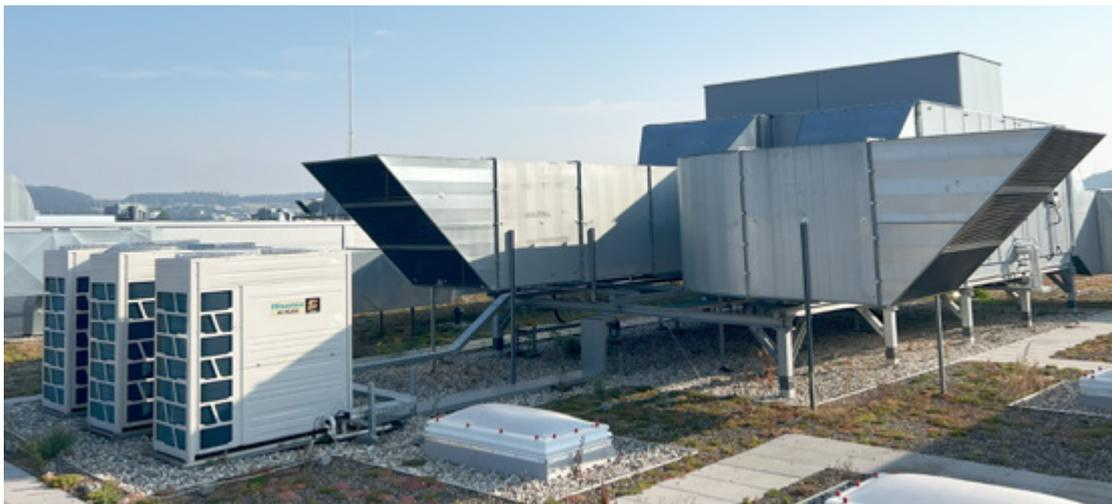
*Die VRF-Außengeräte im Abluftstrom der Lüftungsanlage platziert, um den Wirkungsgrad zu steigern und die Abtauzyklen zu reduzieren.*
