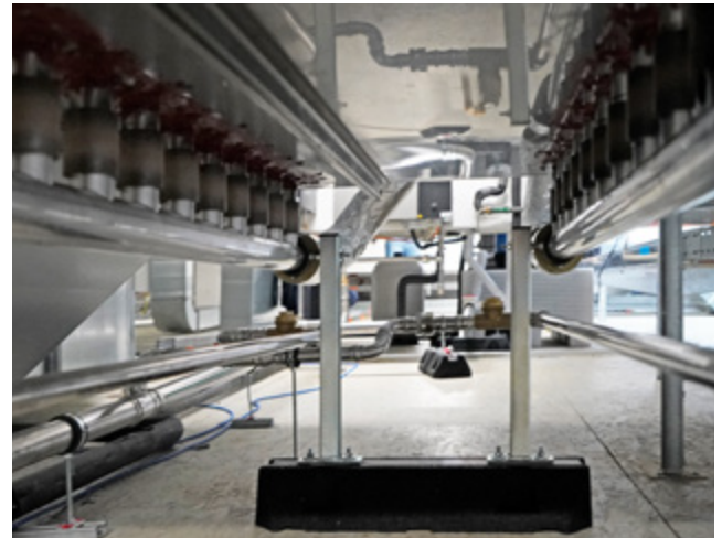
Kein V8, aber ordentlich Dampf: Das Rapid-Sorb System für gleichmäßige und kondensatfreie Dampfverteilung
