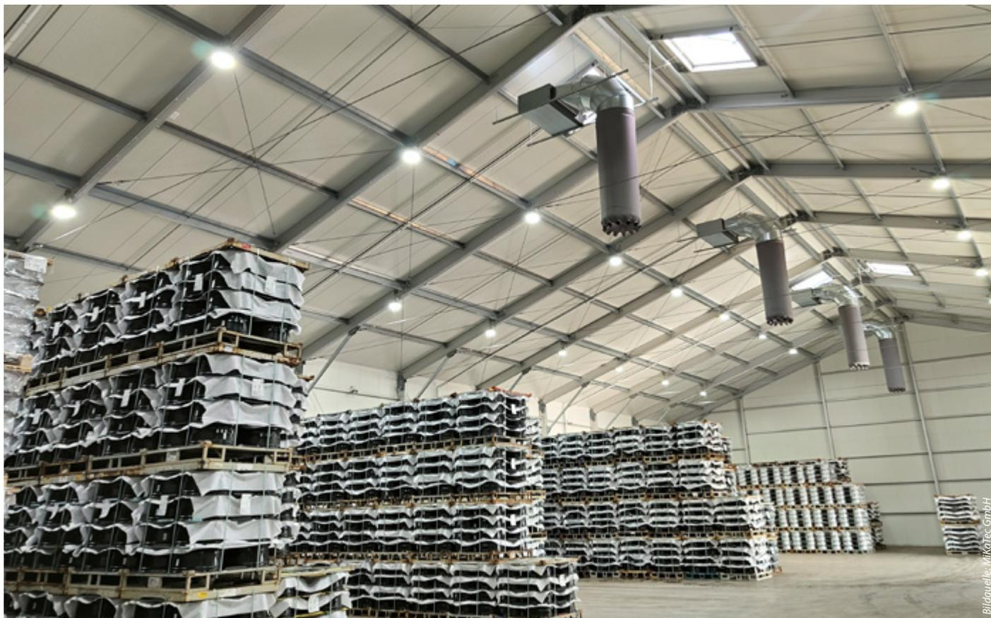
Hisense-Kanalgeräte mit speziellen Luftsäcken zur Sicherung einer gleichmäßigen Luftverteilung
