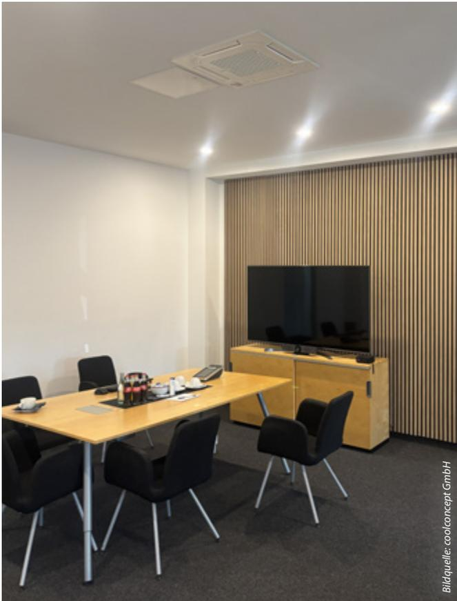
Mini-Kassettengeräte von Hisense mit zugfreiem 360°-Luftaustritt
