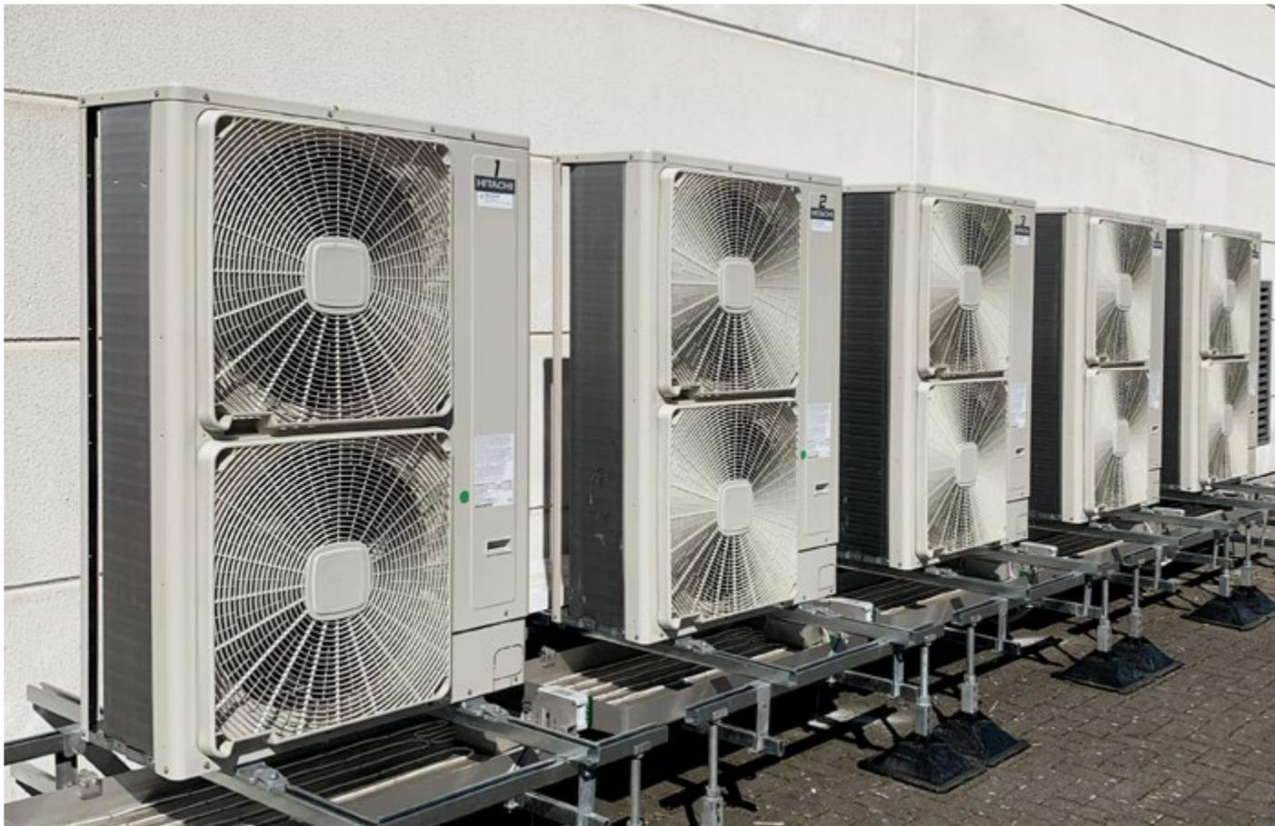
Fünf **Utopia-Außeneinheiten** eingebunden in eine RLT-Anlage sorgen für optimales Raumklima
