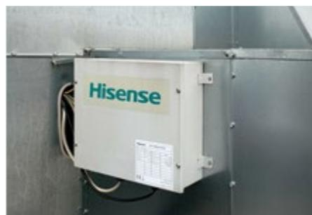
*HZX-Steuereinheiten für ext. Wärmeübertrager*
