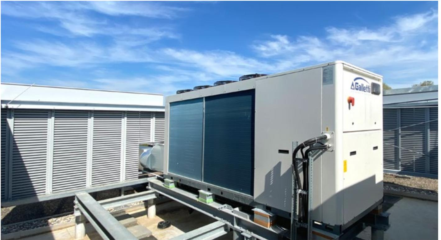
Auf dem Gebäudedach montierte **polyvalente LCP-Wärmepumpe**
