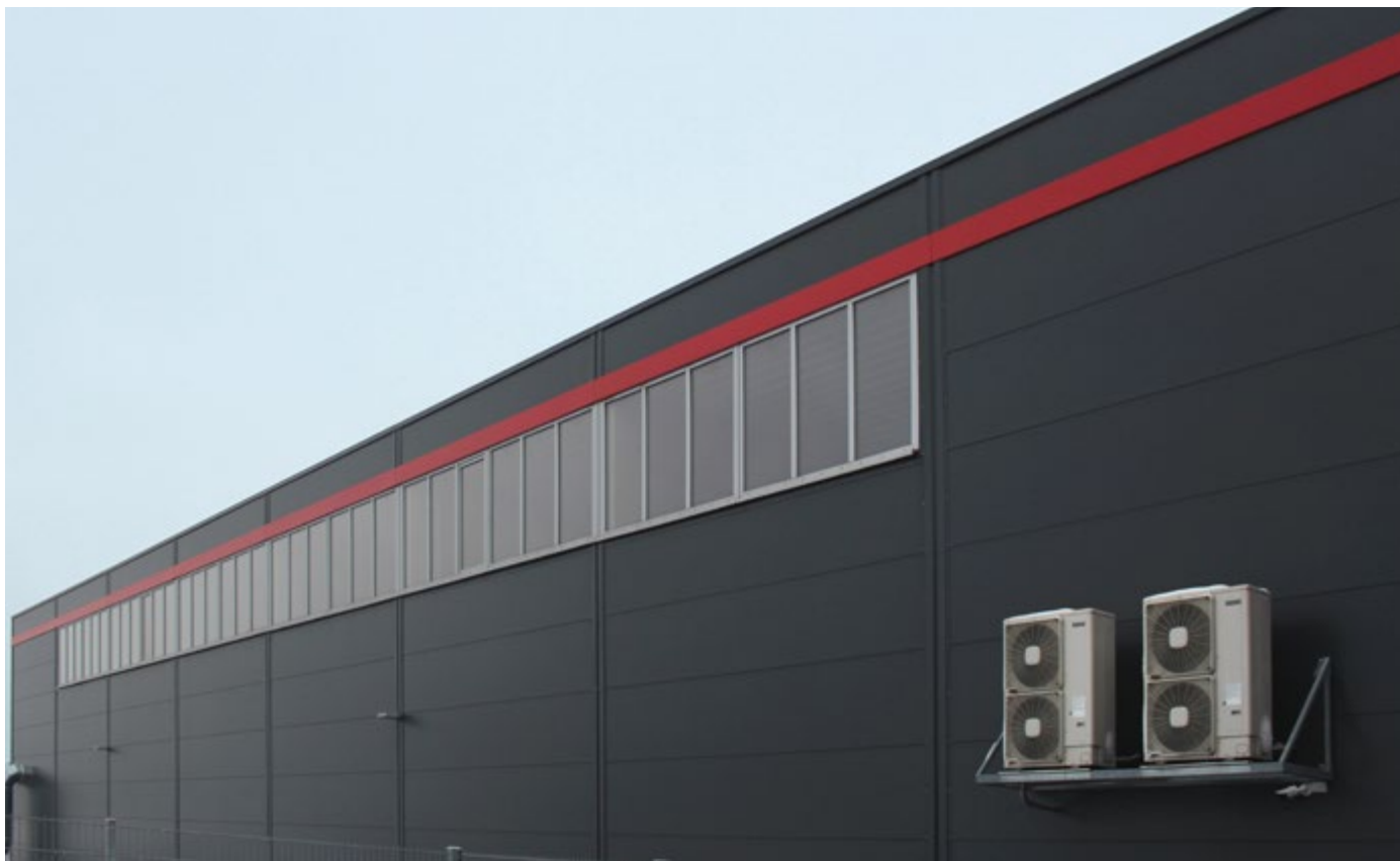
Die Lagerhalle der Zucker Edelstahlschmiede GmbH wird mit Hitachi Luft/Wasser-Wärmepumpen monovalent beheizt
