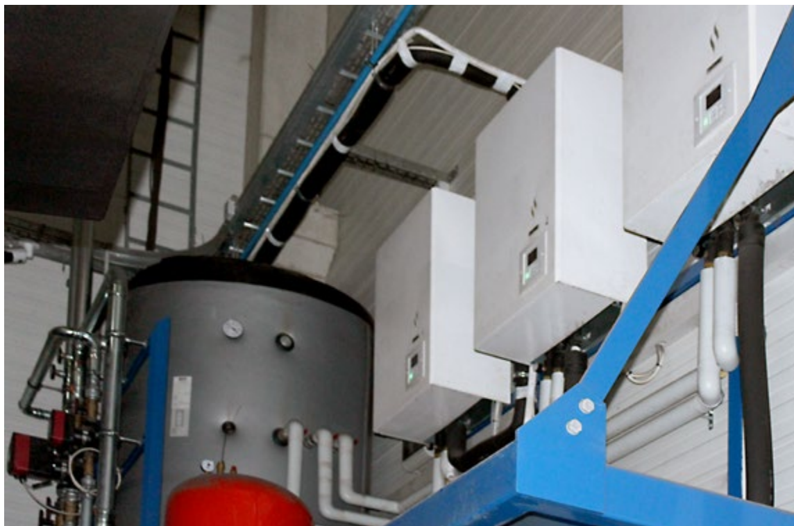
Wandmontage der Yutaki-Inneneinheiten
