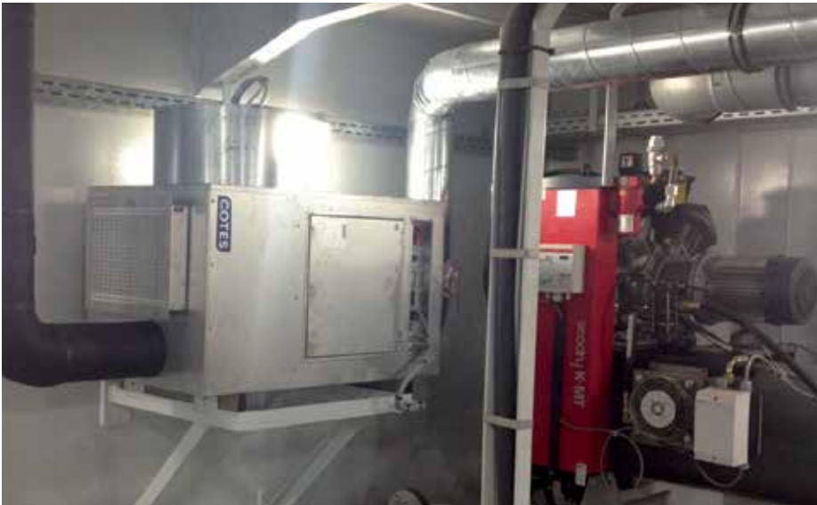
Cotes-Adsorptionstrockner im Pumpenraum des Schiffes
