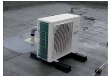
Eine RAM-90 oben auf dem Dach montiert.
