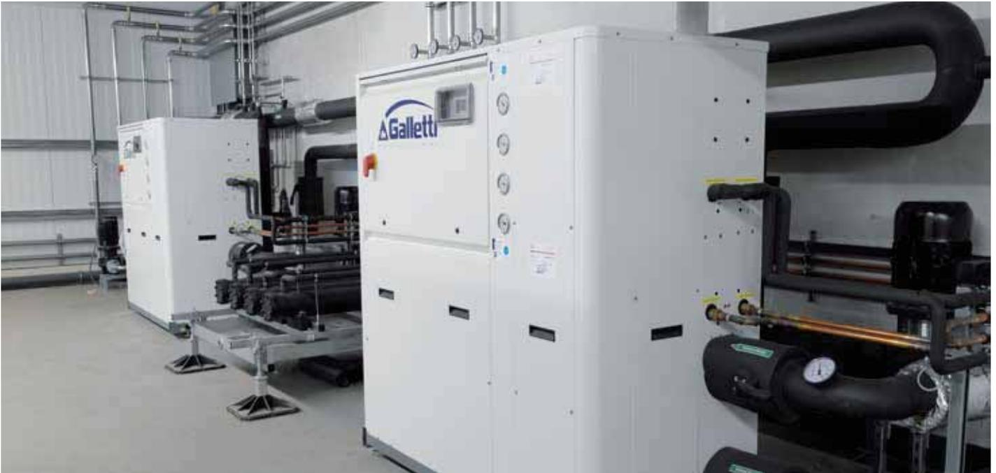
Zwei parallel aufgestellte identische Kaltwassersätze von GALLETTI für einen redundanten, unterbrechungsfreien Systembetrieb
